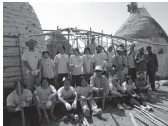
土嚢シェルター建築中 (インド)
