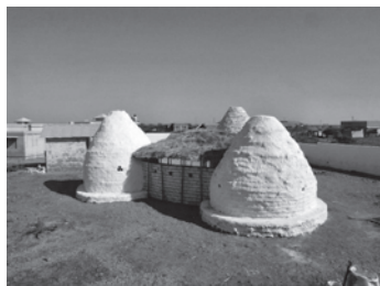
土嚢シェルター完成写真 (インド)
