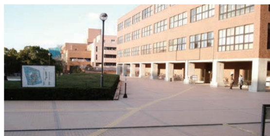
他の手がかりがなく歩きにくい広場に敷設した例
