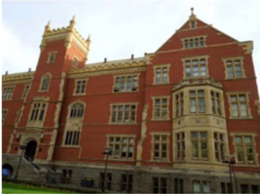
写真 1 アデレード大学校舎
