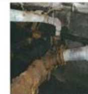
○給排水衛生設備
