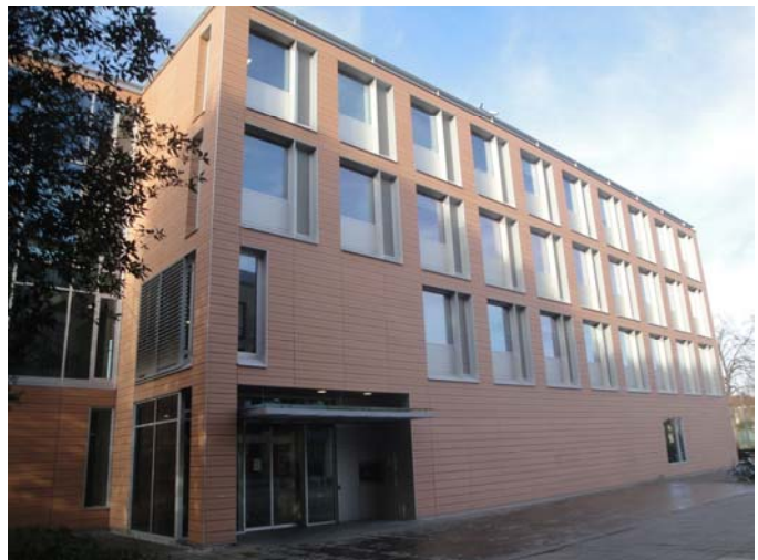
旧 RCEAL が含まれている English Faculty Building
