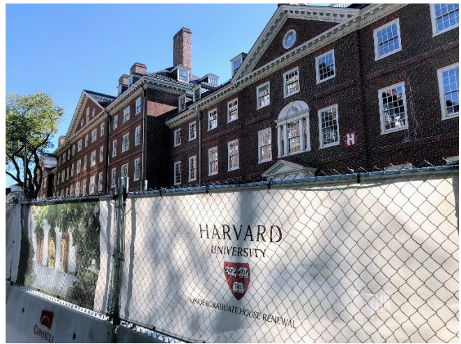
総額 14 億ドル House Renewal (改修工事)中の Lowell House 6
