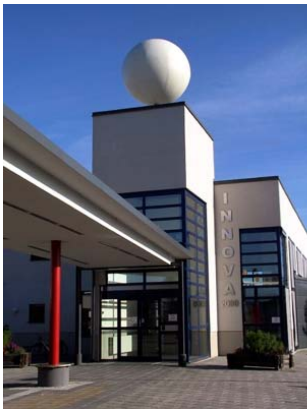
図 20. エントランス
