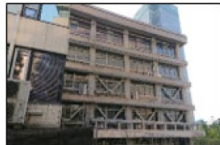
【市谷事務所の外観(改修前)】
