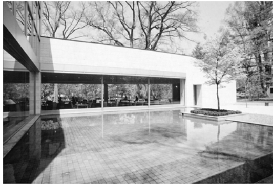
写真1 中庭から見たファカルティハウス
