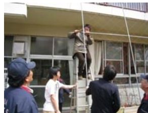
学生ボランティアによる支柱・ネット張り
