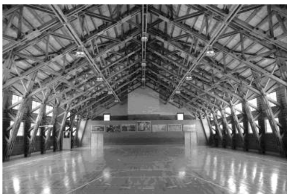
写真1 木造トラス構造体育館
