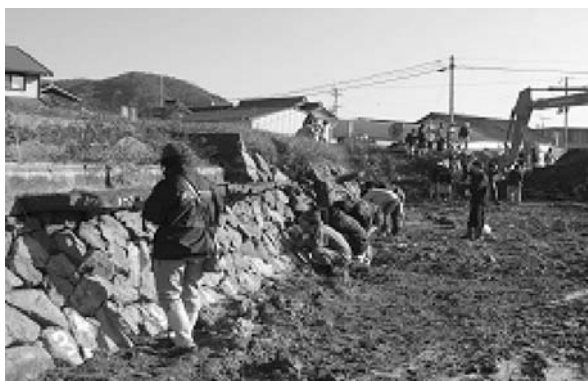
写真5 ため池洗い場の保存作業
