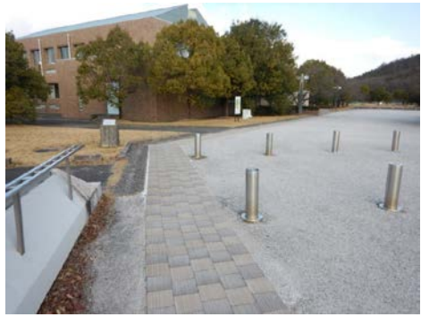
低振動ブロック舗装 (全長約200m)
